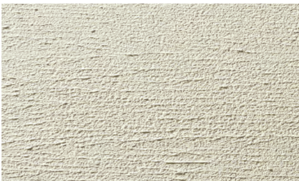
木鏝引きずり仕上げ
